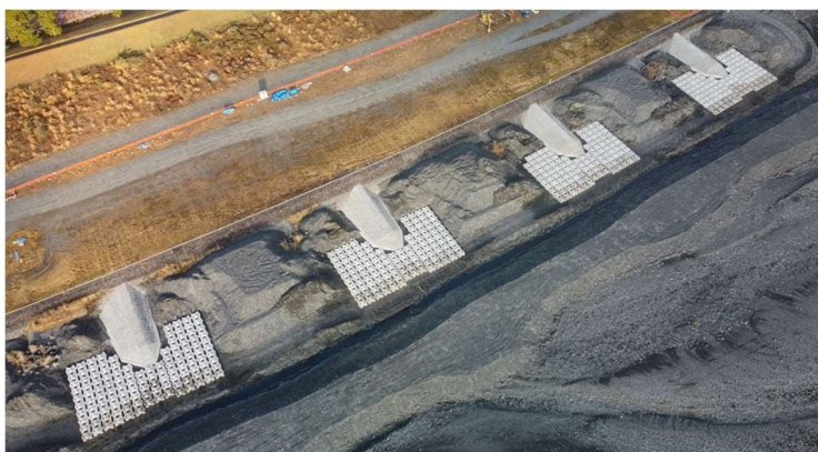
図 7 完成写真（埋戻し前）
