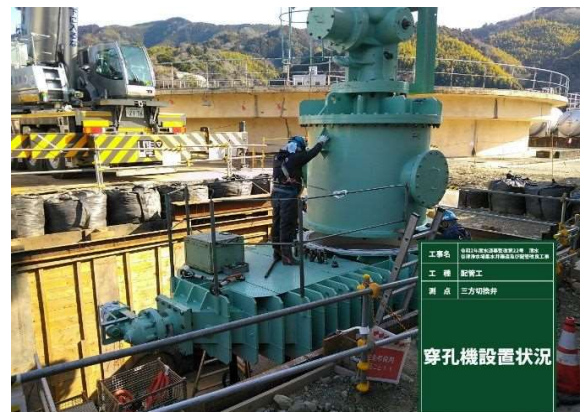
インサ一切换弁穿孔機設置状況
