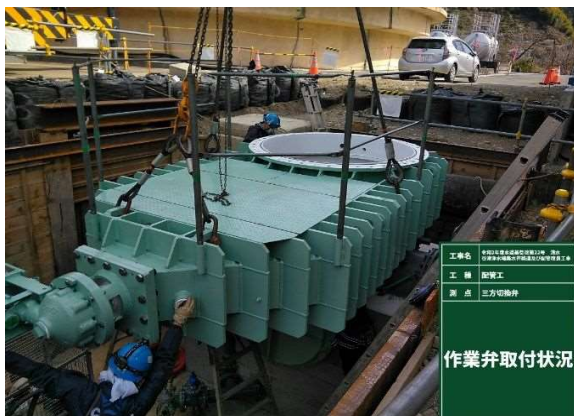
インサ一切换弁作業弁取付状況
