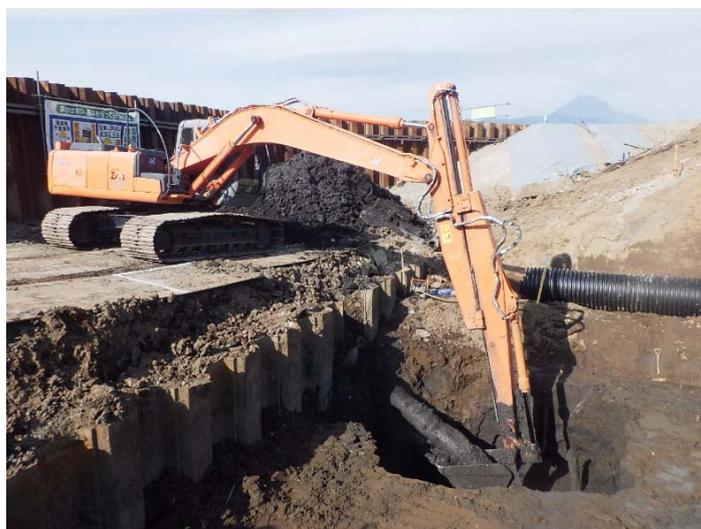
PC杭撤去状況(バックホウスライドアーム式使用)
