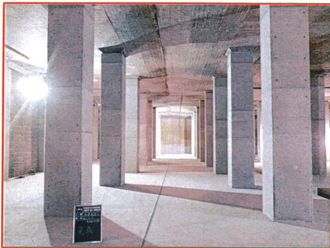
写真-12-1 完成写真(底版部・柱部)
