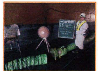
写真-5 槽内空気循環状況
