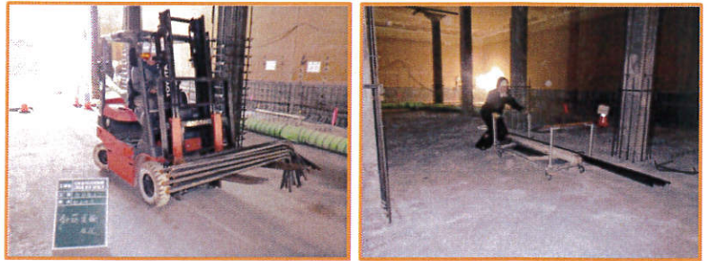
写真-8 材料運搬状況
