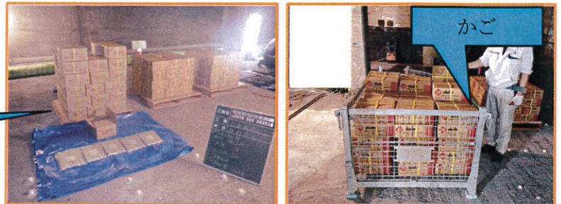
写真-9 材料運搬状況
