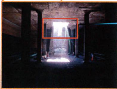
写真-3 搬入口(兼換気口)
