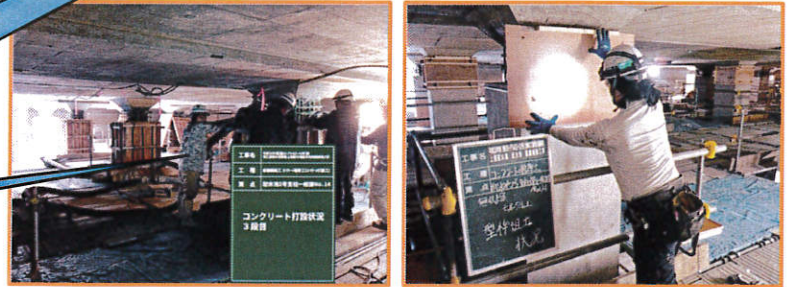
写真-11 型枠組立・打設状況
