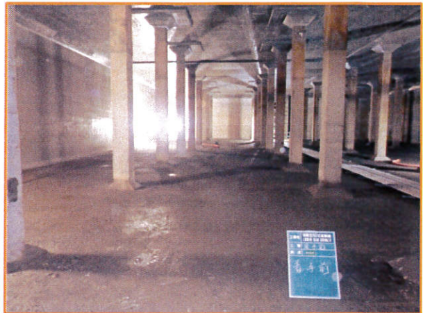
写真-1 施工箇所（貯水槽内）
