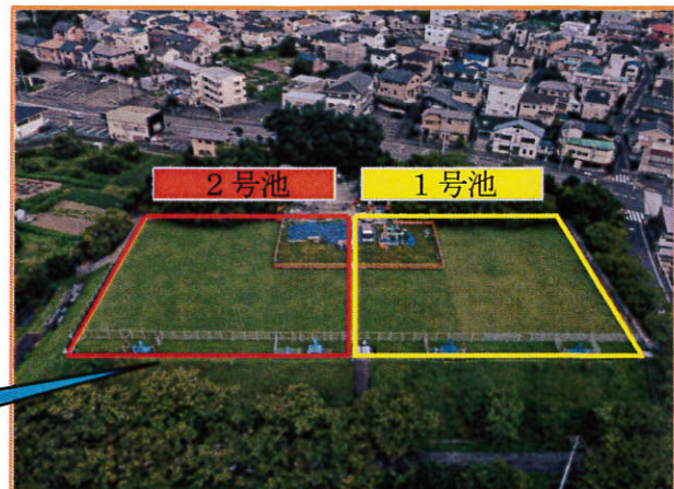
写真-2 施工箇所（外景）
