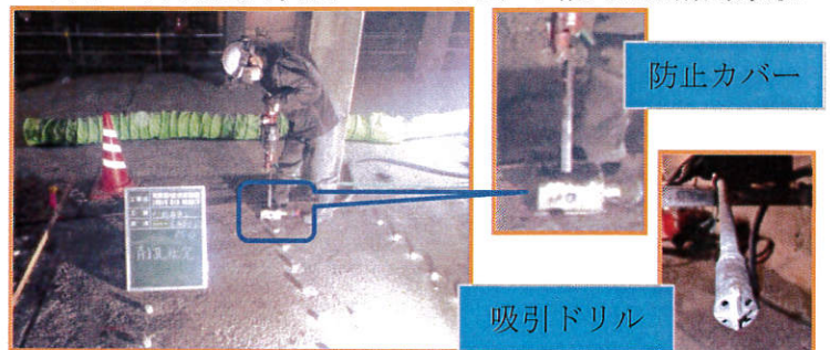
写真-6 削孔時の粉塵防止状況
