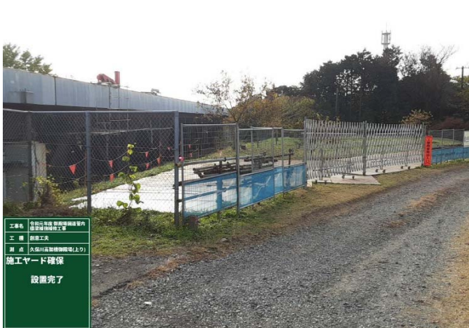
【施工ヤードの確保 全景】
