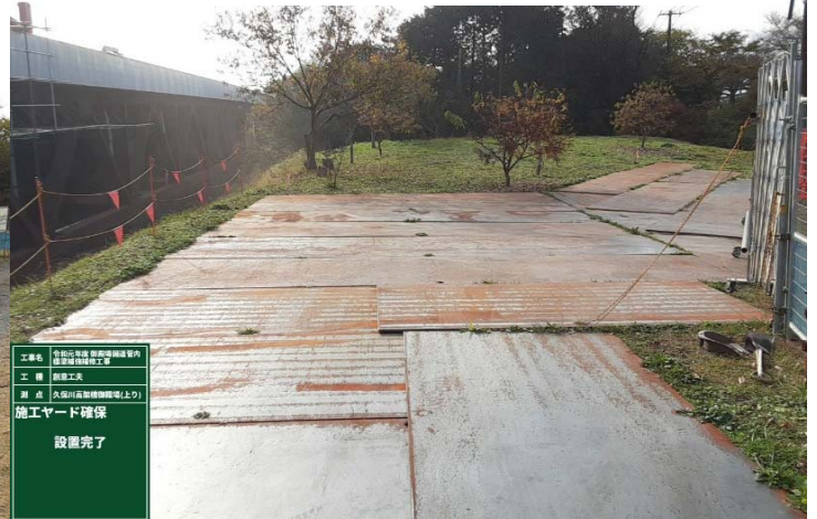
【施工ヤードの確保 敷鉄板敷設完了】
