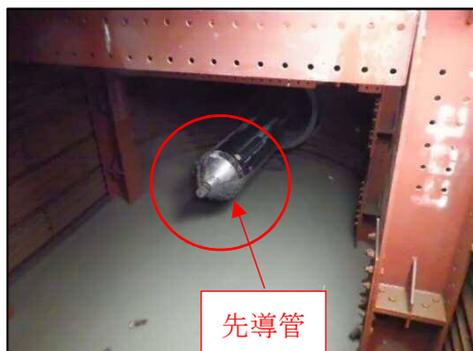
写真9 先導管を用いた引込状況-1
