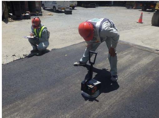
設定した温度により施工可能であることが確認でき、転圧機械・転圧速度も問題ないことが確認できた。転圧回数については切取供試体試験結果より1工区・2工区ともに規格値の96.0%以上の締固め度を満足する結果が得られた。また、1工区と比較し2工区の方が締固め度が増加傾向になったので締固め度が高い2工区の転圧回数【初期転圧5回、2次転圧9回】を採用した。
