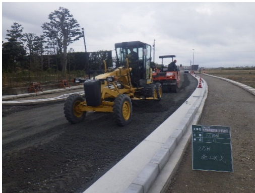
下層路盤施工狀況
