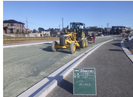
上層路盤施工狀況
