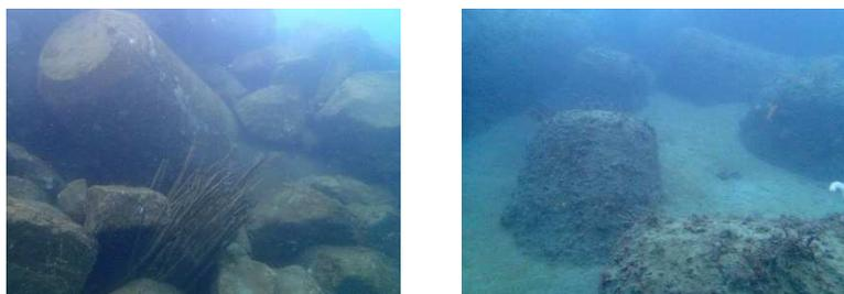
写真：水中消波ブロックの状況（法面は被覆石に、法尻は土砂に埋没していた）
