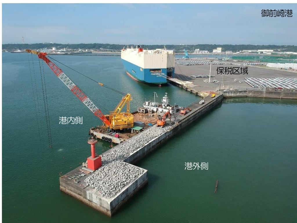
工事概要写真：水中部ブロック撤去(掘削・撤去)、上部コンクリート取壊し
