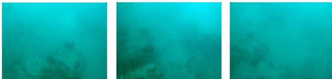
写真：水中被覆ブロックの状況（土砂（浮泥）に埋没し突起部でブロックと判断できる状況）
