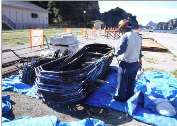
被覆ブロックの製作ヤードは冬季の西風が強く吹き付ける場所でもあり、強風時には西側の岸壁に打ち付けた海水がしぶきとなって肌の露出部分には痛いほどに打ち付ける場所でもあります。鉄筋には当然養生シートをかけますが、時には、これだけの重しをしたのにシートが・・・というときもあります。そこで、鉄筋にラスタクエンチあるいはサビラーズなどの防錆剤を散布し、塩分を含んだ空気からさえもサビを抑制する対策をとり、鉄筋の養生を施した結果、鉄筋の品質低下を防止することが出来ました。
