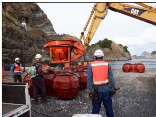
ブロック製作において、型枠上あるいは足場上からの転落災害の要因を無くすため、コンクリート打設用のホッパーをアタッチメントによるバックホウ一体型のものとして製作作業を行った結果、常に作業性が良く、冬季の季節風が比較的強く吹くような日でも、ホッパーの振れを止めるような手間も無く、安全且つ効率良くブロック製作を行うことが出来ました。
