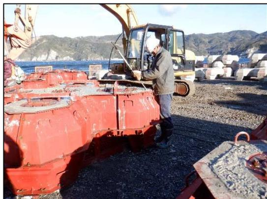
上記①に記載したピカコンを、ブロックの天端まで打設が完了した時点でザックリと挿入し、手で振動を与えながらゆっくりと、エアーが抜けていくのを確認しながら引き抜いていくことを根気よく繰り返したことにより、美観向上につながりました。担当の職人には頭が下がります。
