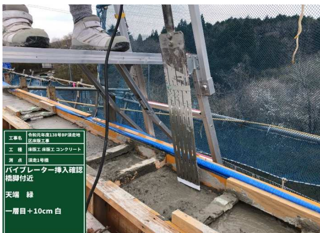
面状バイブレータ使用状況
