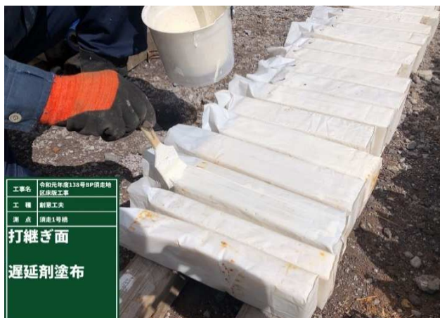
型枠への遅延剤塗布
