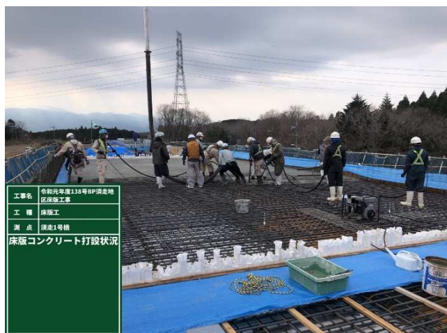
低勾配側からのコンクリート打設
