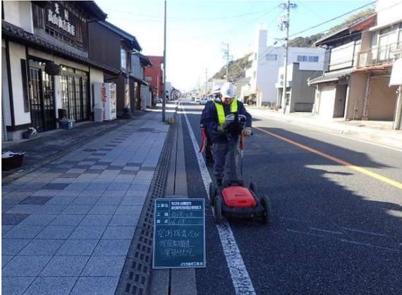
空洞探査機にて埋設物調査
