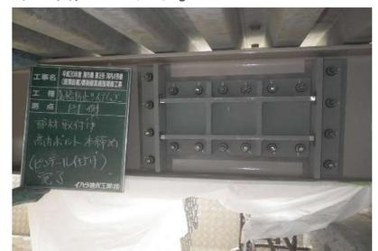
高力ボルト締め付け完了
