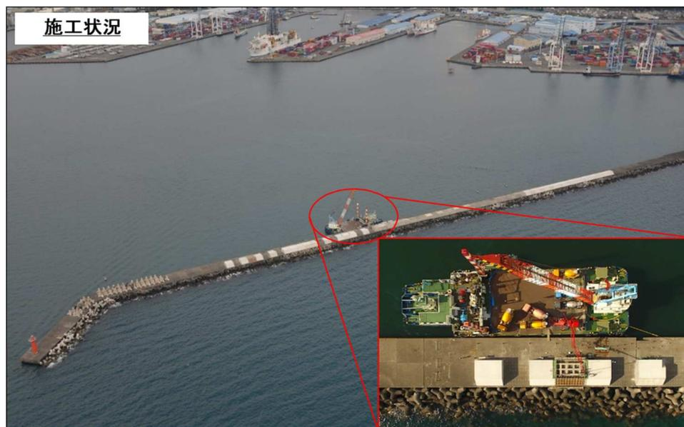
起重機船に積載可能な生コン車の台数は、使用した起重機船の大きさとコンクリートポンプ車のスペースおよび生コン車の動線を考慮し6台とした。また、1スパン当たりの打設数量は約144m<sup>3</sup>のため、打設日においては岸壁と防波堤を1日6往復する。
