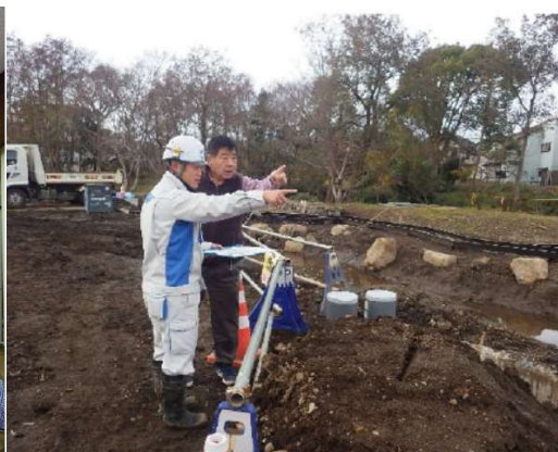
グラウンドワーク三島との現場打合せ
