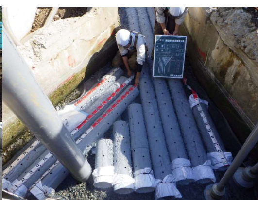
湧水暗渠排水管施工
