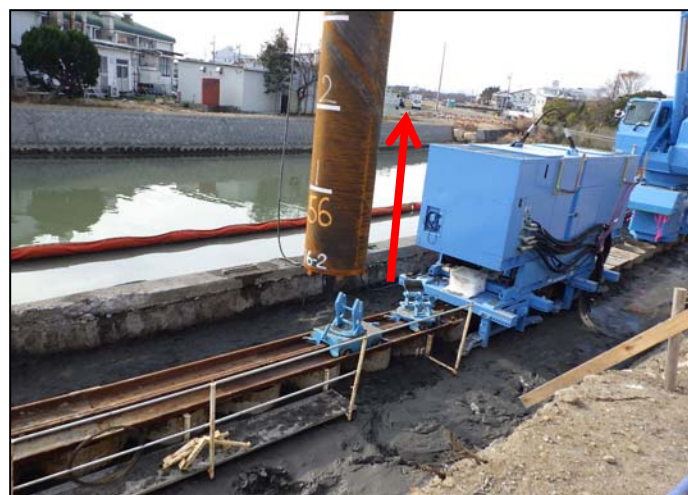
(写真 1-3) 鋼管矢板を真上に吊り上げる。
