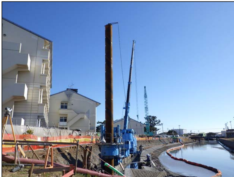
パイランナー(鋼管矢板運搬状況)
