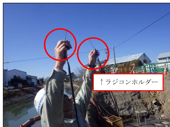
(写真 3-4) 遠隔操作で安全に玉外し
