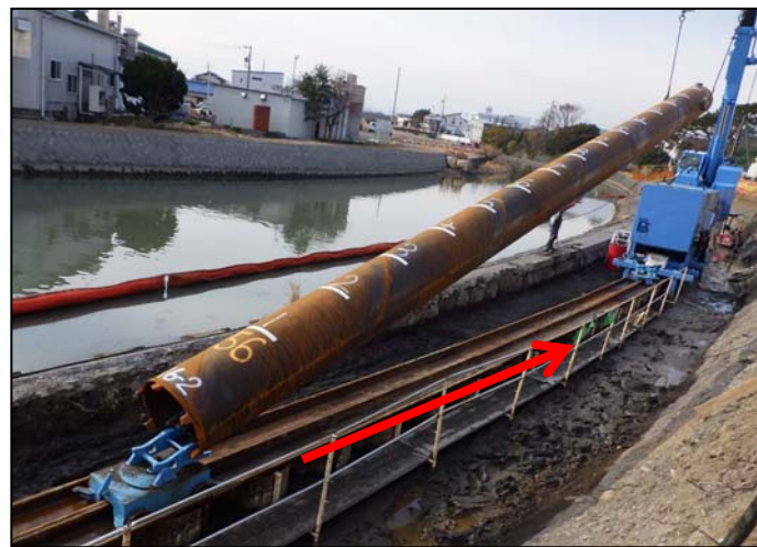
(写真 1-2) 矢板に沿ってスライドする。
