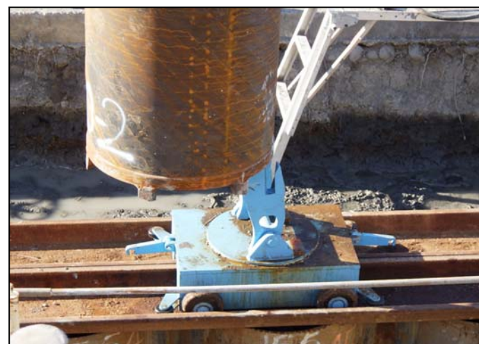
(写真 1-4) 鋼管矢板を真上に吊り上げる。
