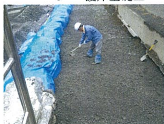
今回人力整形状況 A 大型土嚢工について
