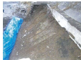
盛土整形直後の完了
