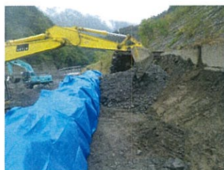
BH0.7使用 土砂施工
