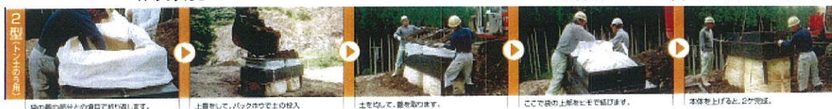
大型土嚢作製工程
