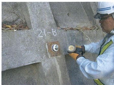
頭部キャップ交換 ロックボルト頭部補修状況 油脂挿入状況
