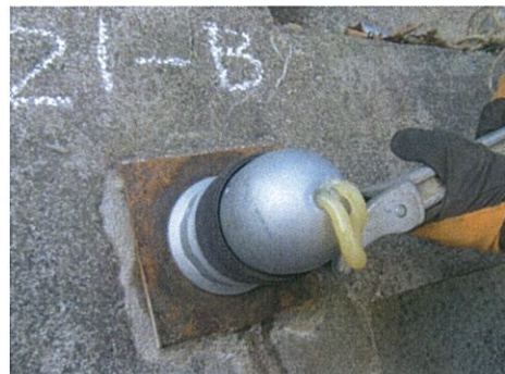
頭部キャップ交換 ロックボルト頭部補修状況 油脂挿入確認
