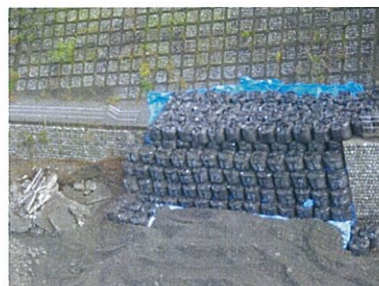
耐候性大型土嚢 200袋 施工完了
