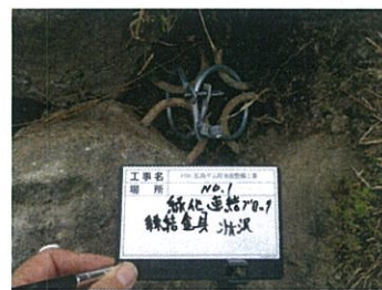
大型ブロック設置状況 連結金具取付は現在生産して いる類似品を使用した。
