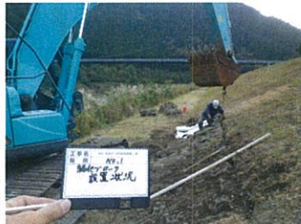
大型ブロック設置状況
