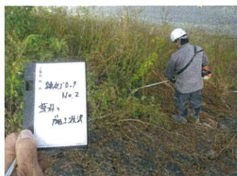
施工前の草刈りの状況により 施工範囲を確認しました。
