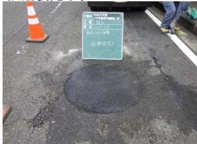
③ 舗装構成分撤去し鉄板で仮蓋をする。
