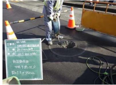
④ 調整ブロックを使用し、天端を合わせる。
