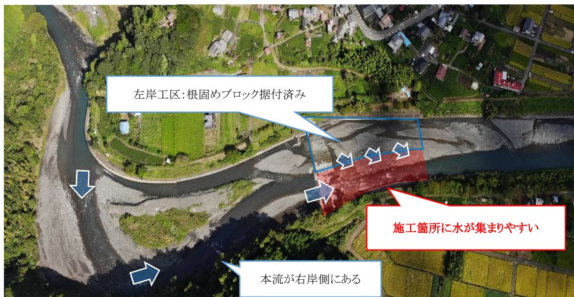
写真3 河川の形状(施工前)
