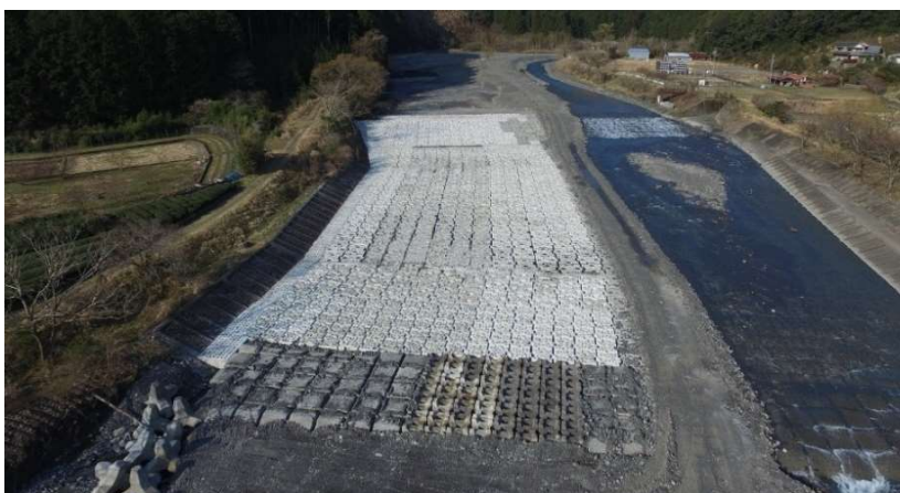
写真9 施工完了 (下流を望む)
