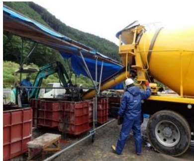
写真6 雨天時のコンクリート打設
