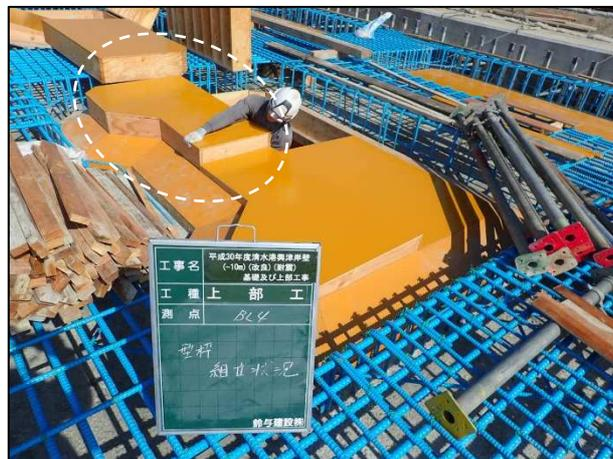
箱抜き部スラブ型枠施工状況
