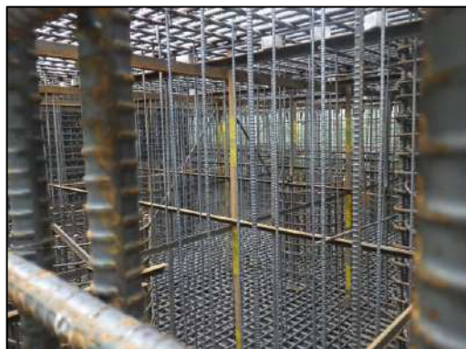
※機械式鉄筋定着体 写真-⑤
