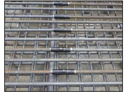
※機械式鉄筋継ぎ手 写真-④
