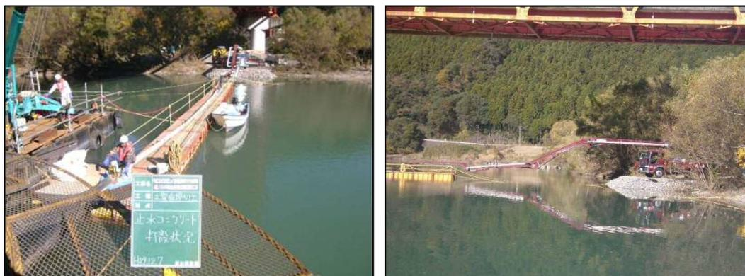
写真 ロングブームポンプ車+浮棧橋を利用したコンクリート打設状況
