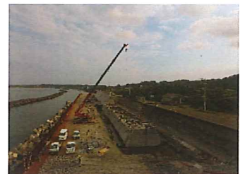
施工状況 (終点から起点を見る)
