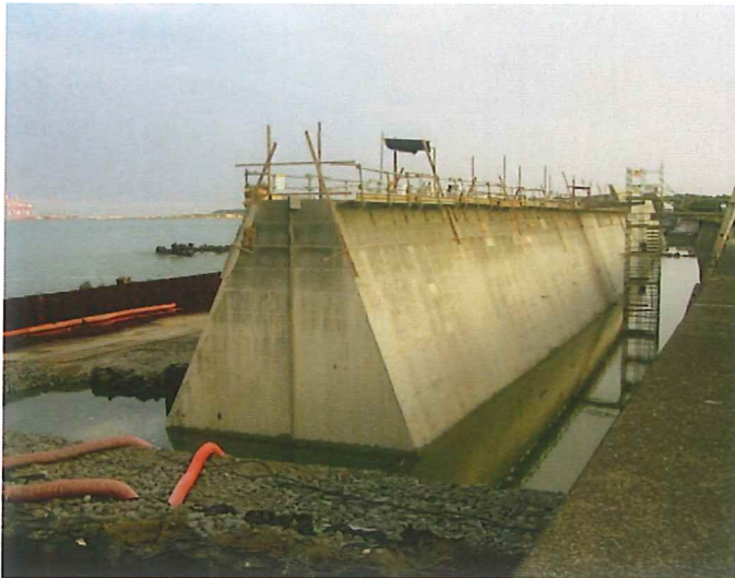
施工状況(終点から起点を見て)
