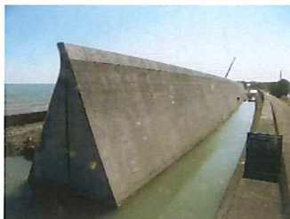
完成 (山側背面終点から起点を見る)
