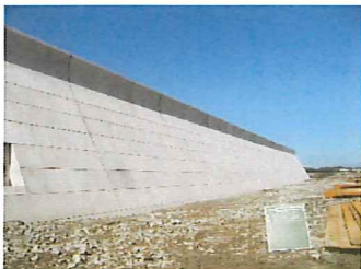
完成 (海側正面起点から終点を見る)
