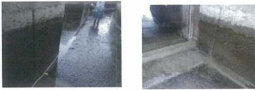
断面修復工(着手前)
