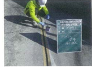
断面補修工(目地工)
