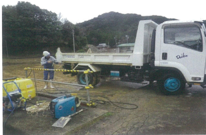
図-5：ダンプタイヤ洗浄
