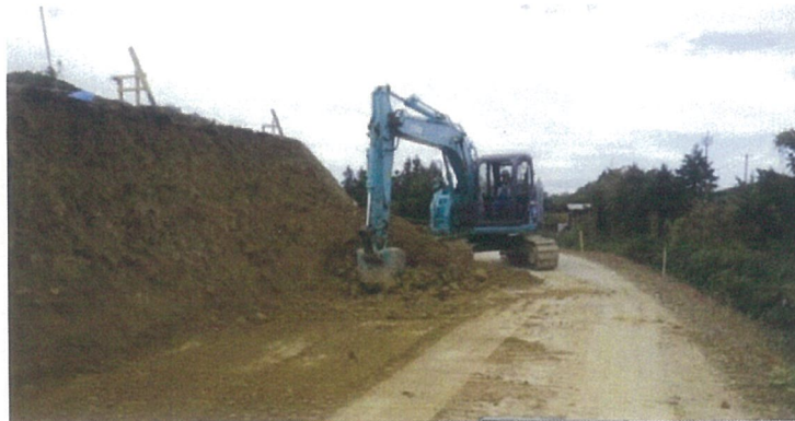
図-2：山留ブロック部
