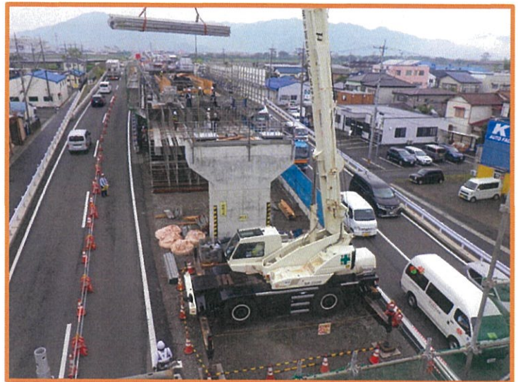
写真-3 交通規制状況(下り線側1車線規制)
