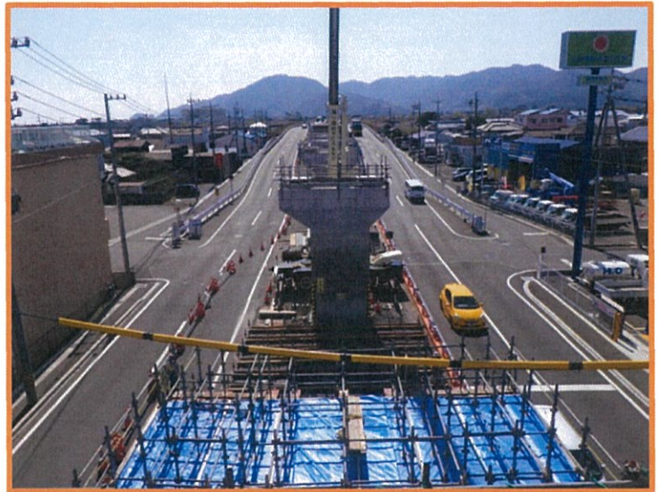
写真-4 資機材荷上げ施工状況
