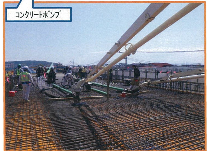
写真-6-2 コンクリート打設状況
