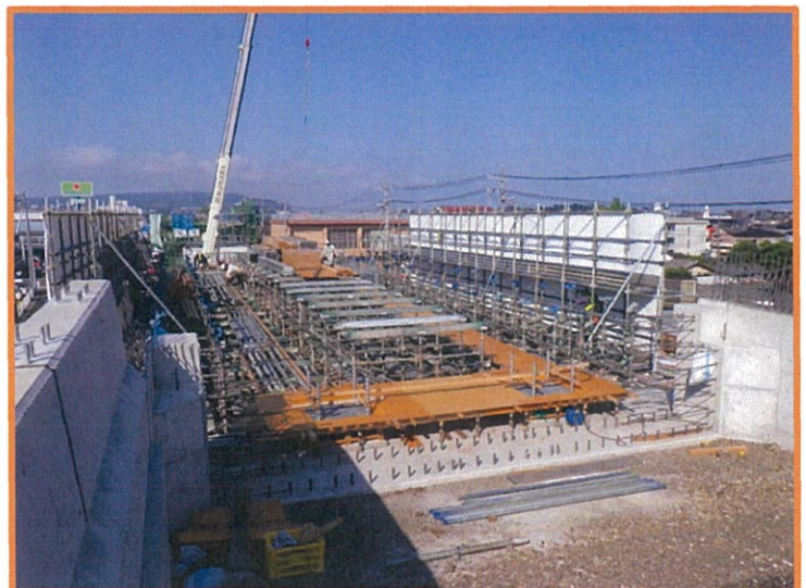
写真-5 資機材荷上げ運搬状況
