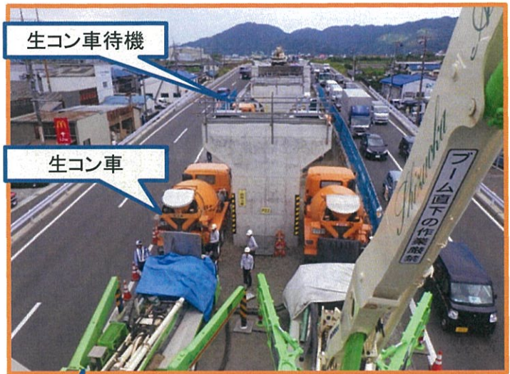
写真-6-1 コンクリート打設状況
