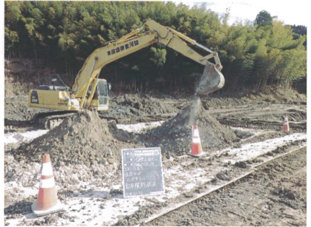
・改良ヤード 攪拌状況
