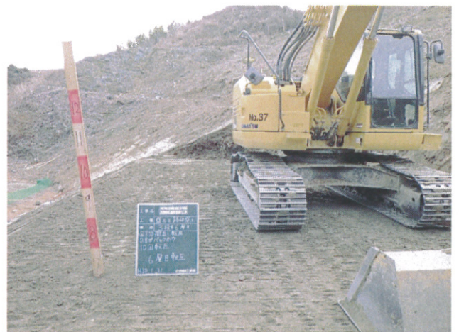
・養生1日以上での改良土転圧
