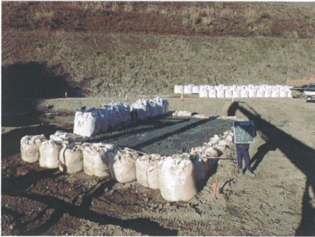
・改良ヤード 土砂投入
