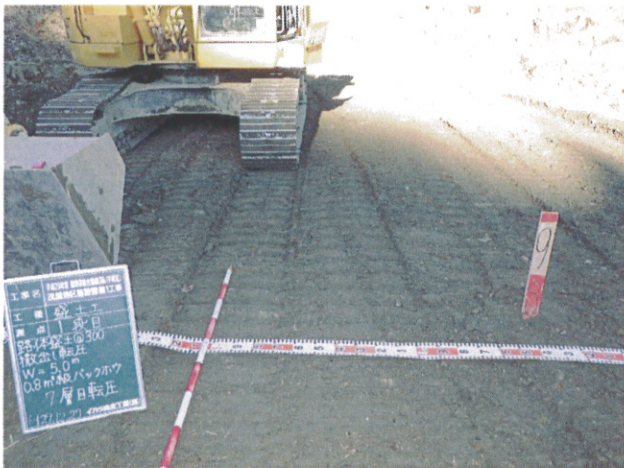
・養生0日での改良土転圧
