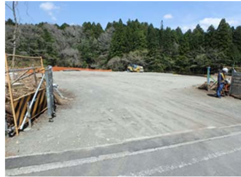
写真-2 施工ヤード完成
