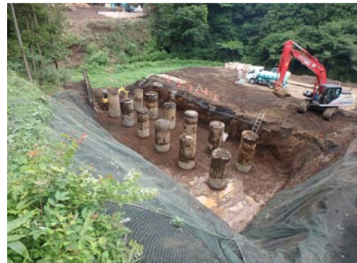
写真-3 床掘状況
