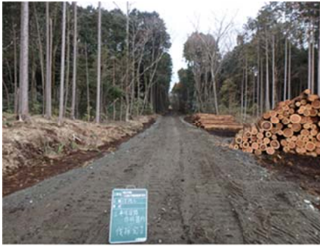
写真-1 工事用道路完成
