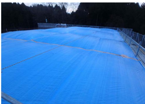
写真-8 寒中養生実施状況(頂版)
