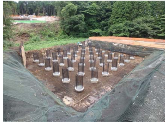
写真-5 杭頭処理完了
