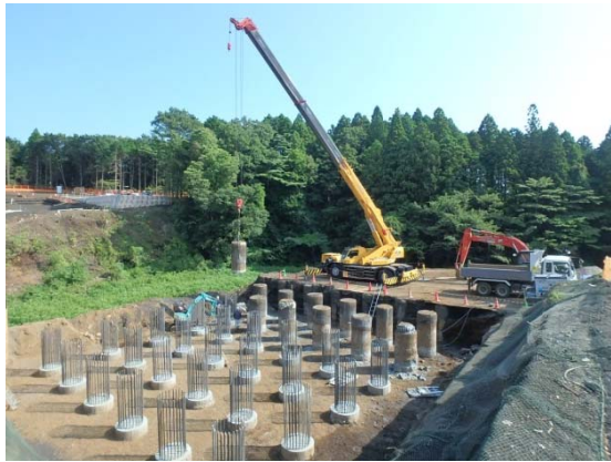
写真-4 杭頭処理状況
