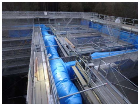
写真-6 寒中養生実施状況(壁部)
