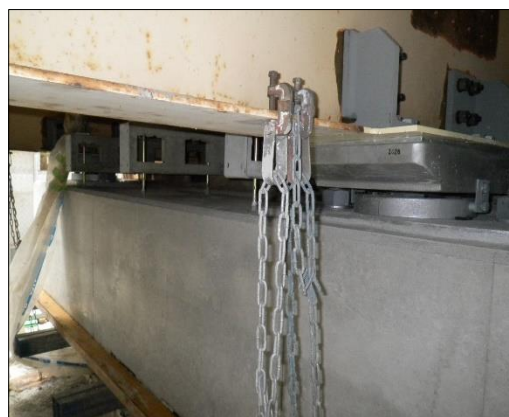
写真4・吊支保工設置状
