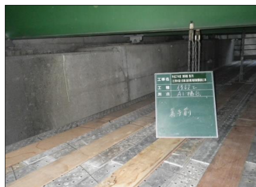
SK パネル（写真5・右）と在来の吊り足場（写真6・左）の床面の比較
