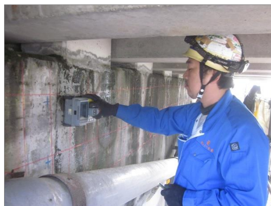
写真1・既設橋脚側面の鉄筋探査状況
