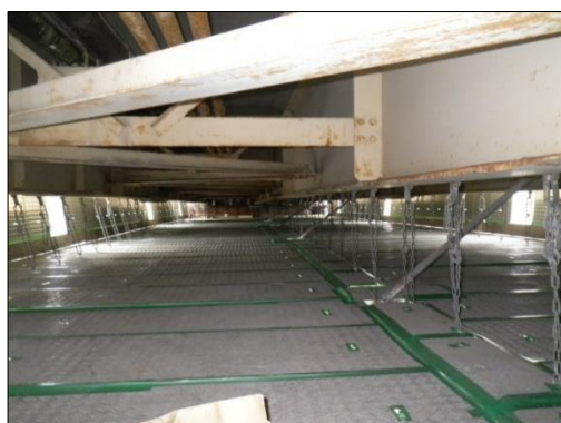
SK パネル（写真5・右）と在来の吊り足場（写真6・左）の床面の比較
