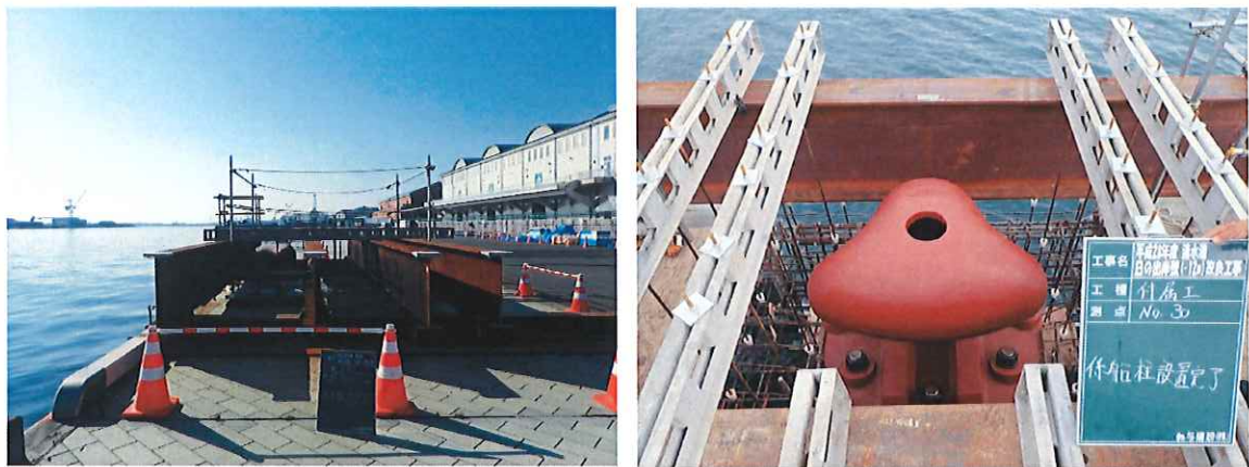
写真-3 吊支保工法施工状況写真
