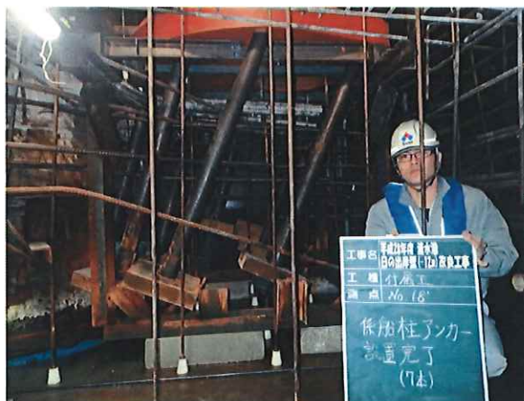
写真 3. 係船柱設置完了
