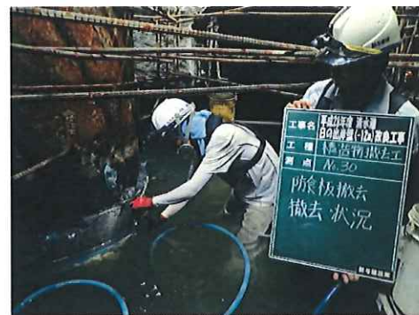
写真 3. 干潮帯における施工状況写真
