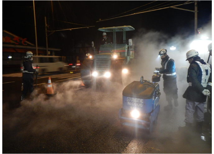
写真-4 転圧状況
