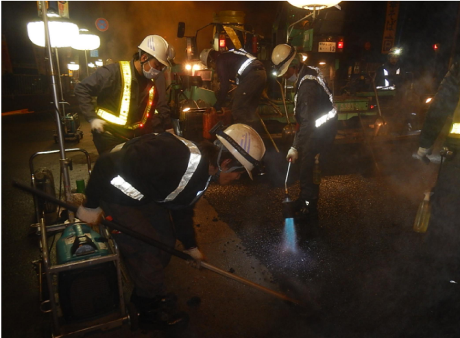
写真-3 端部仕上げ状況
