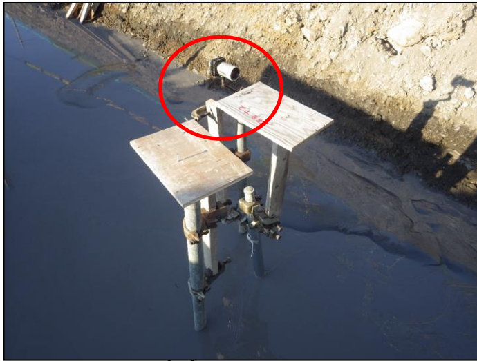
(写真 4-2 パイルレーザー)
