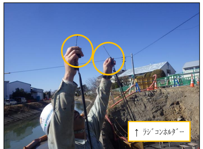
(写真 2-4) 遠隔操作で安全に玉外し
