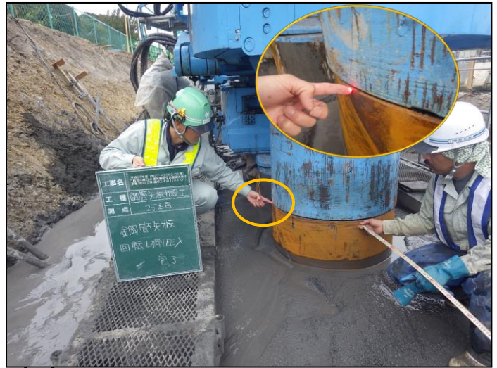
(写真 4-3 照射レーザー部)
