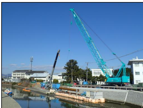
施工状況 (ジャイロプレス工法)
