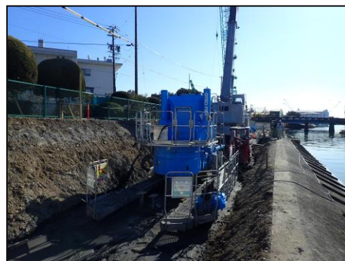
施工機械 (ジャイロパイラー)
