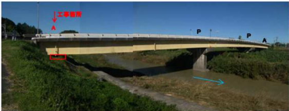
側面(下流側より)
