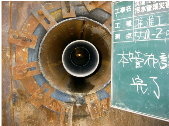
《本管挿入完了》
