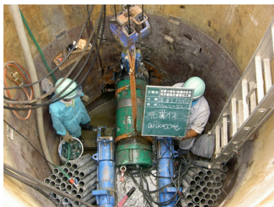
《先導管回収(φ2000 発進立坑)》
