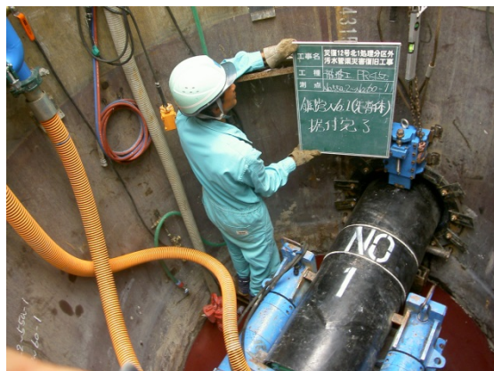
《先導管据付、推進》
