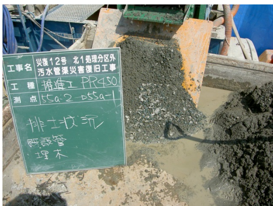
《泥土回収、排土》
