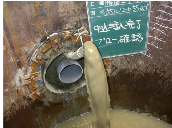
《中込注入確認》
