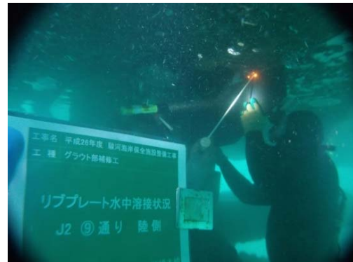
写真 6-2 リブプレート溶接取付け
