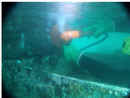
写真 4-5 溶接部の研磨
