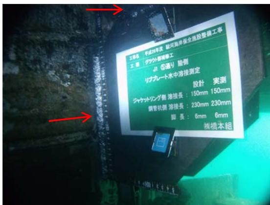
水中溶接完了 溶接長 確認状況
