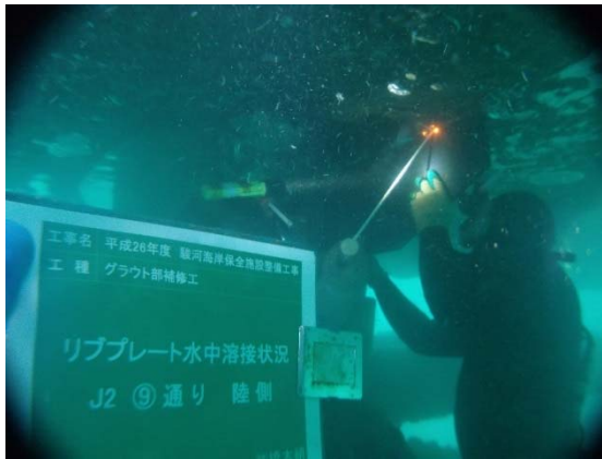
水中溶接の作業状況 リブプレート取り付け(2名体勢)
