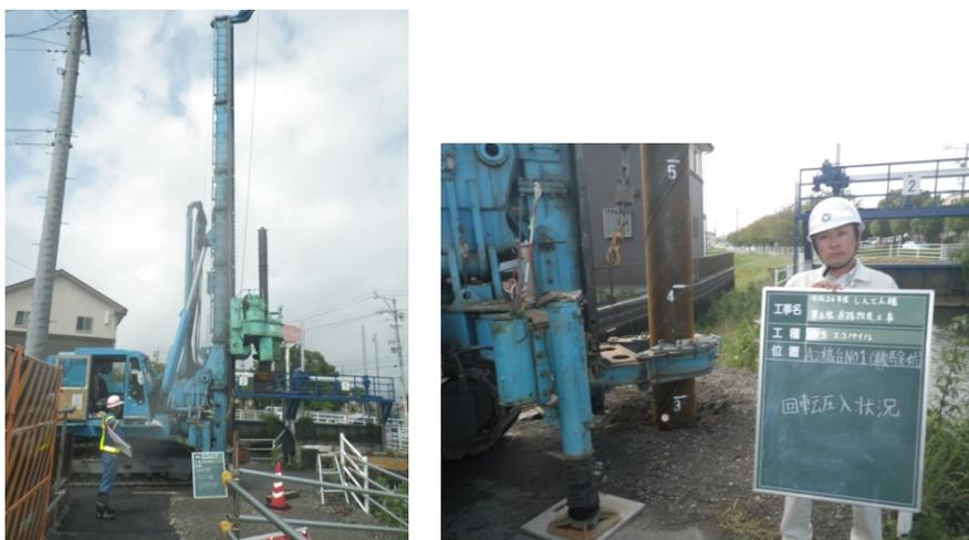
地表面にある最終位置にて偏心量を確認して、ロットにより定着位置まで下げて行きます。
