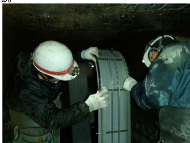
※本体製品(CFエレメント)は偏平にした状態(写真3参照)で坑内に入れ組立て(鋼材フレームを取付け矩形に整形)設置する。
