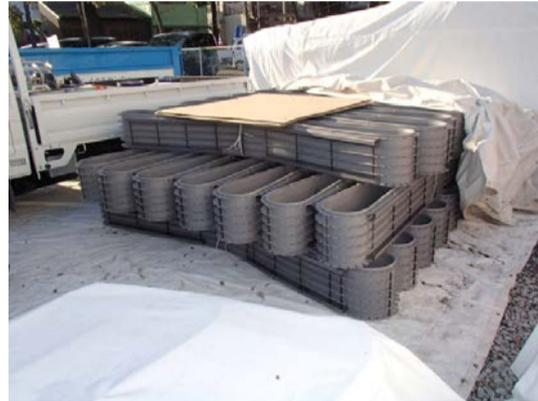
現場周辺は大型車両進入禁止のため、資材は納入日を十分打合せし、材料切れを起こさぬ様早期の発注を行ないました、そして小型の車両を使用し増便する事で予定数量に対応しました。また、使用資材は前日に必要数を作業車両に積込み準備、作業スペースを少しでも多く確保するよう努め、使用車両は必要最小限の大きさの車を用意しました。場内はフォークリフトを使用し資材の整理整頓をこまめに行ない、スペースを有効利用出来る様心掛けました。施工ヤードはこの他にも、充填材(袋セメント/25Kg)納入時の大型車両搬入可能用地も必要でしたので町外に資材置場を用意し、そこから小運搬を行ない作業を進めました。
