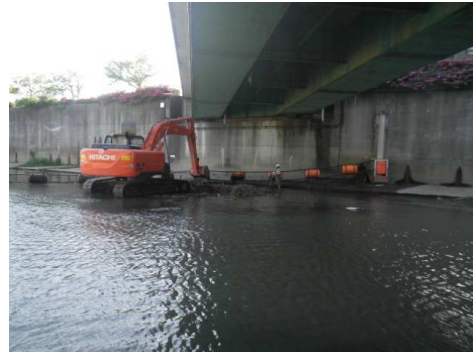
大谷川放水路ゴミ取りネット清掃状況
