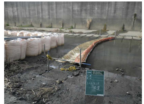
シルトフェンス設置状況
