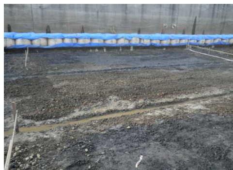
調整材不陸状況
