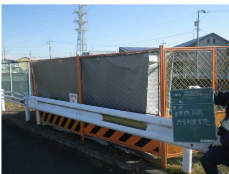
発電機 防音シート設置状況
