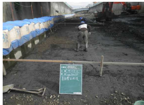
基面整正状況
