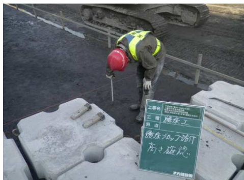
据付前高さ確認
