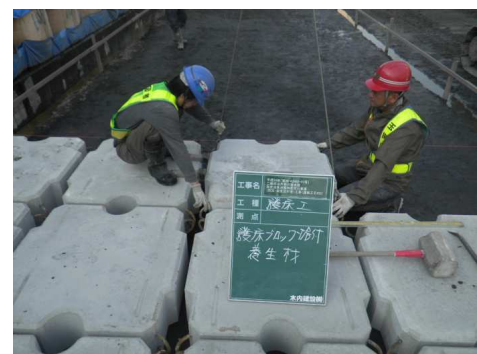
養生材を使用し隙間間隔確保
