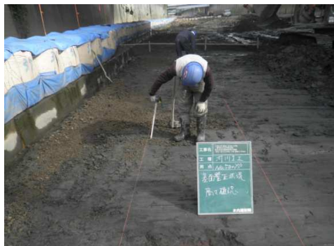
丁張り設置後高さ確認
