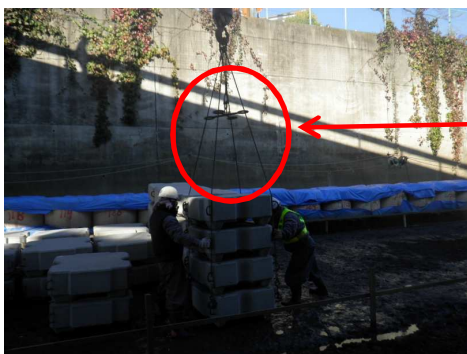
吊金具の絡み防止器具の使用
