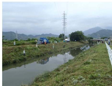
巴川堤防清掃状況
