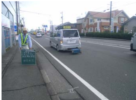
上り線・走行車線 NO. 18付近
