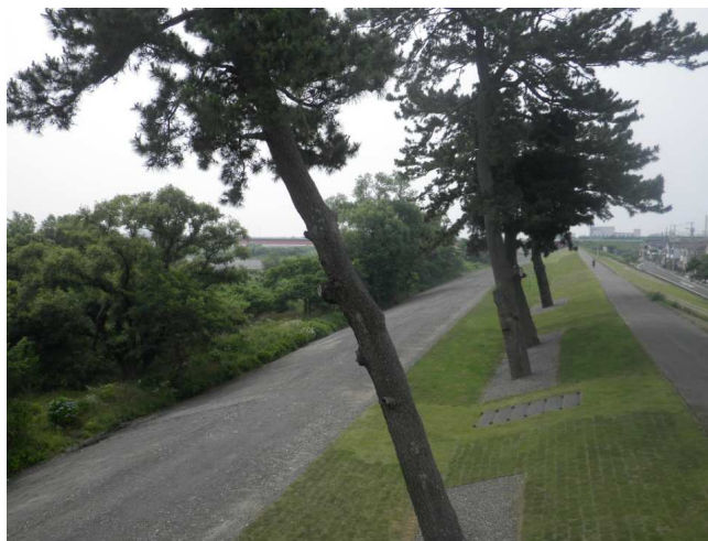
高水護岸工事完成写真
