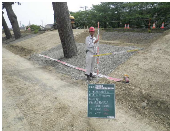
単粒碎石盛土状況
