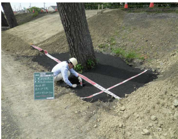
墨チップ施工状況
