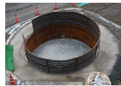
⑨ 打設完了
