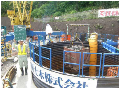
② 坑内より土砂搬出
