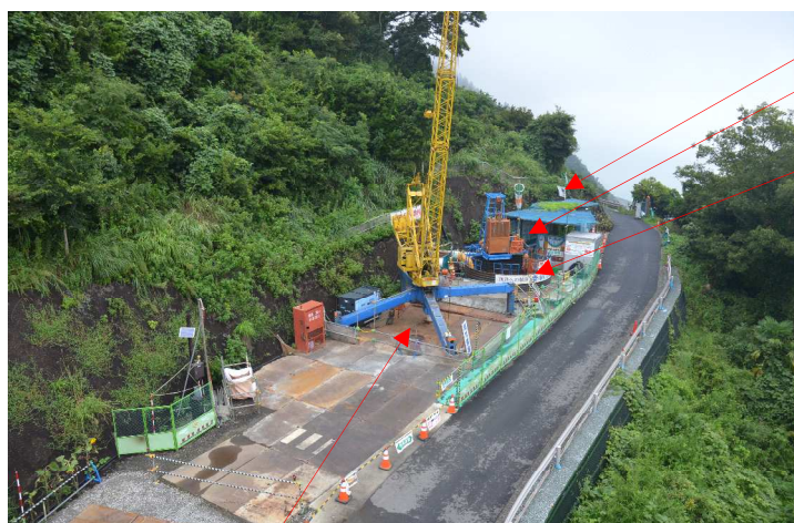
傾斜地仕様ジブクレーン(2.9t吊)
