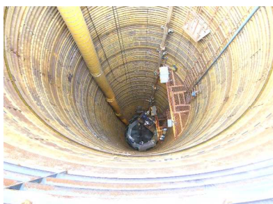
⑦生コン打設(下方打設の為骨材分離対策) ⑧ライトウエイトホースを使用して対策
