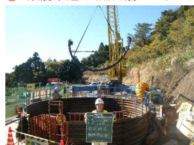
⑤ 鉄筋吊込み(配力筋D25)
