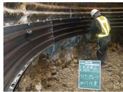
③ ライナープレート取付け
