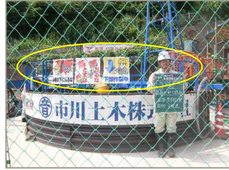
転落防止柵・標識設置
