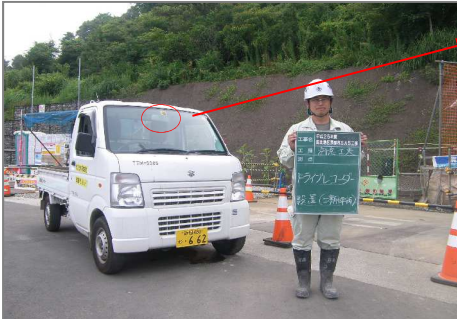
工事用車両にドライブレコーダーを設置
