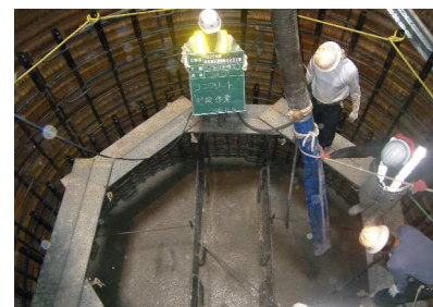
⑦生コン打設(下方打設の為骨材分離対策) ⑧ライトウエイトホースを使用して対策
