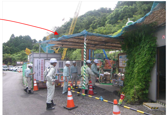
暴風による飛来防止対策の為、スダレをネットにて覆いました。
