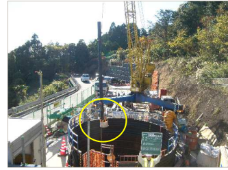
主筋の抜け落ち防止
