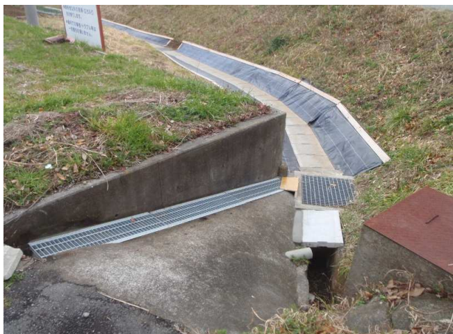
歩行者通路確保 グレーチング蓋設置後
