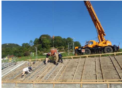
法枠工 均しコンクリート打設
