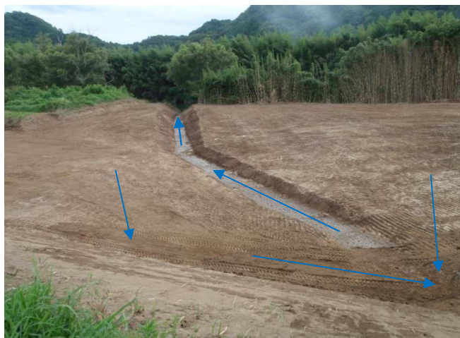
排水対策 土側溝設置完了
