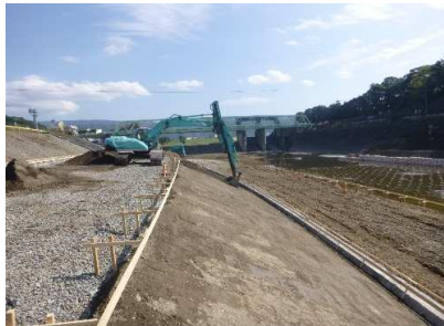
法枠工 法面整形
