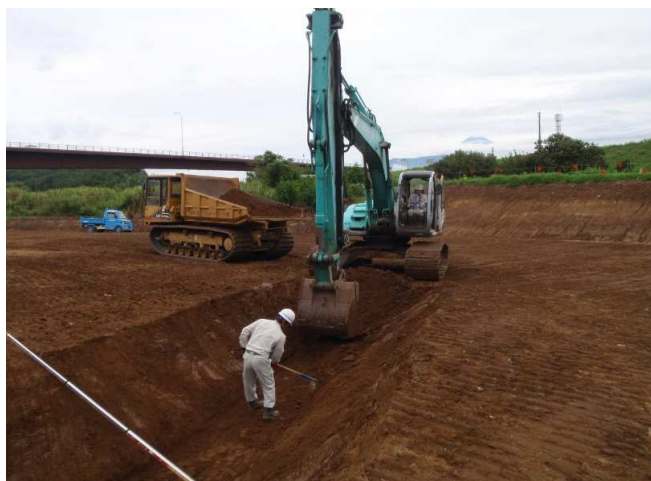
排水対策 土側溝掘削状況
