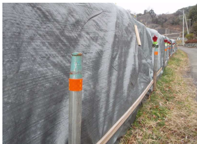
接触事故防止対策 反射テープ貼付け状況
