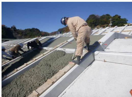
転倒防止対策 コンクリート打設時、作業足場
