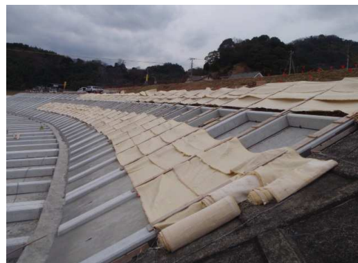
飛散防止対策 養生マットを堅固に敷設
