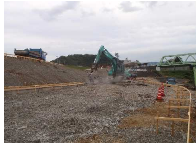
既設護岸取壊し
