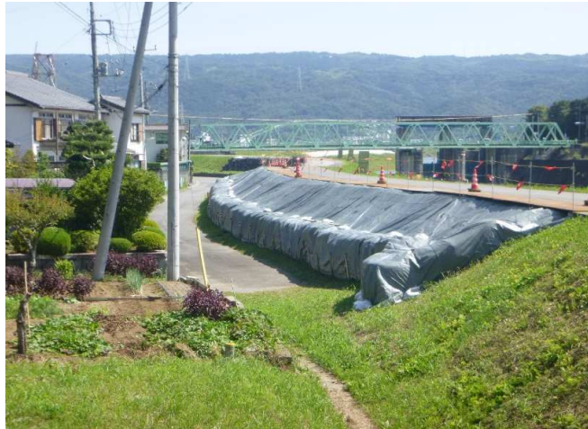
防塵対策 法面シート養生状況
