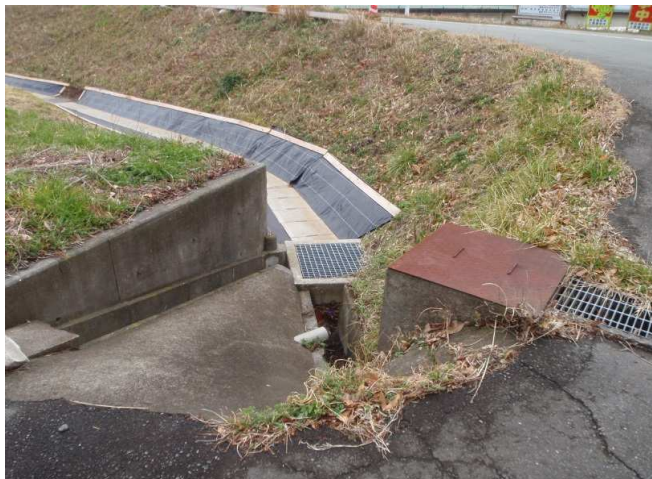
歩行者通路確保 グレーチング蓋設置前
