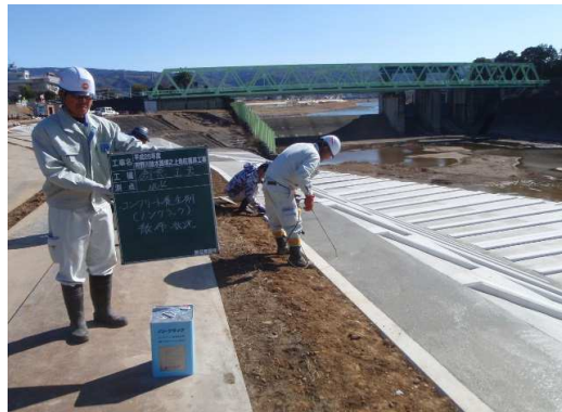
コンクリート養生剤(ノンクラック)散布状況 平場コンクリート部
