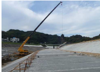
法枠工 縦枠・すべり止め等据付
