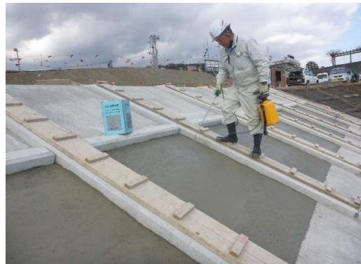
コンクリート養生剤(ノンクラック)散布状況 法面コンクリート部
