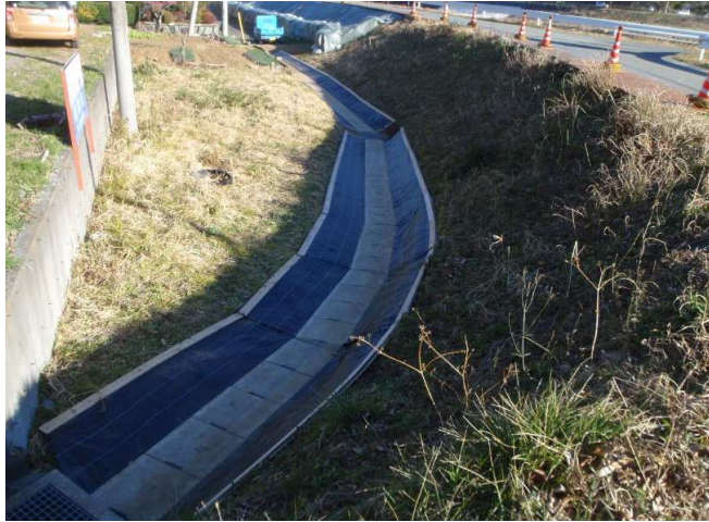
防草シート設置状況
