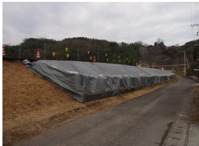
防塵対策 法面シート養生状況
