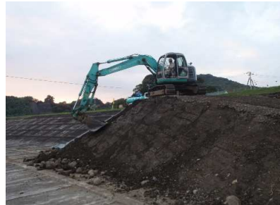
工事用道路築造
