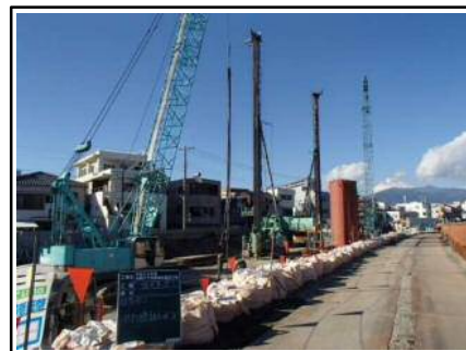
2台の杭打機で施工
