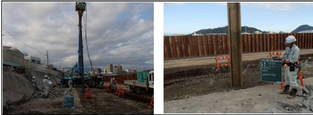
鋼矢板による試験打設
