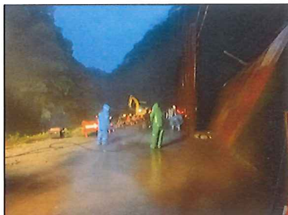
土砂流出対応状況 (事前に照明車・重機・人員を待機)
