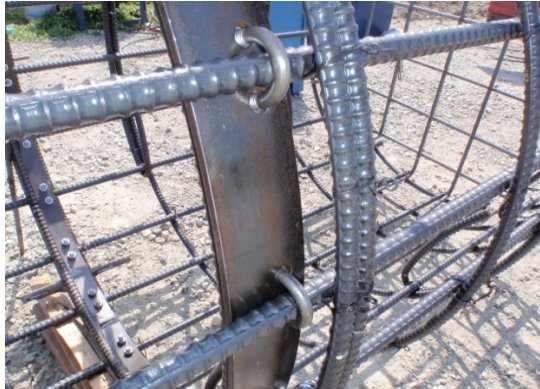
U字ボルトとフラットバーを使用しての無溶接組立状況
