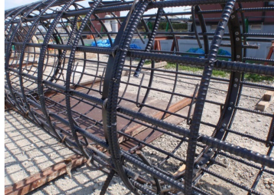
U字ボルトとフラットバーを使用しての無溶接組立状況
