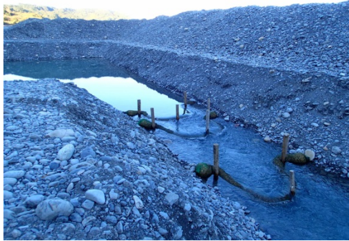
写真 6-6 沈砂池の濁水対策フィルター3列
