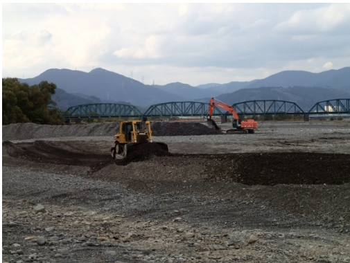
写真 6-3 仮締切工：施工状況
