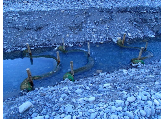
写真 6-6 沈砂池の濁水対策フィルター3列
