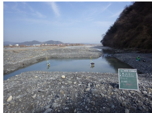
写真 6-5 仮排水路工及び沈砂池
