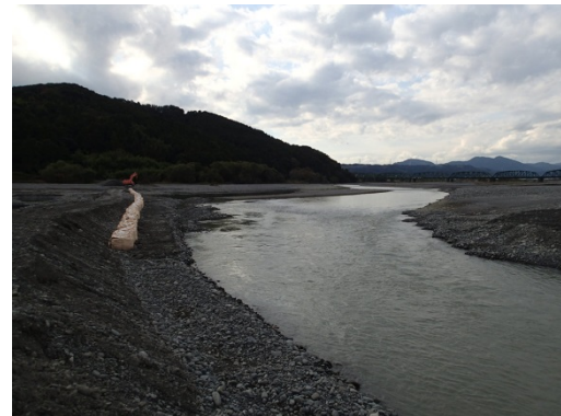
写真 6-4 仮締切工：施工完了
