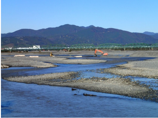
写真 6-1 瀬替え工：施工状況
