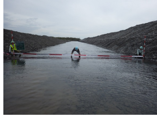
写真 6-2 瀬替え工：完了測定
