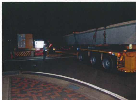
夜間PC桁搬入作業
