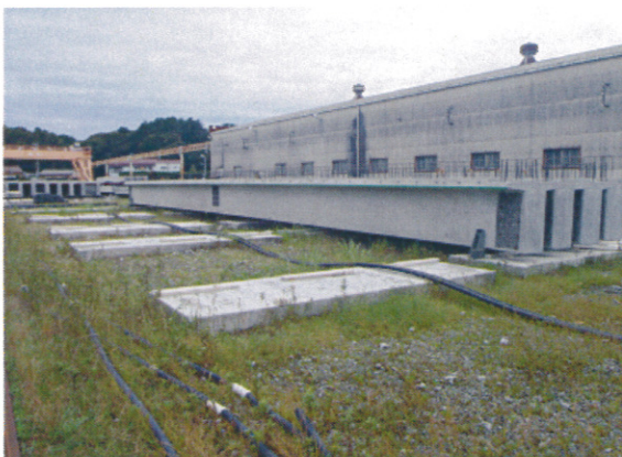
PC桁工場出荷前
