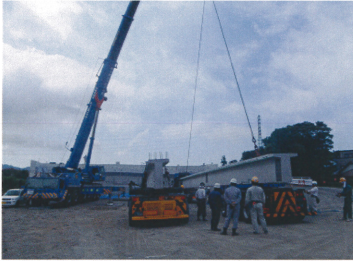
300tクレーンによる架設状況
