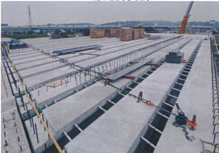
PC桁架設完了状況
