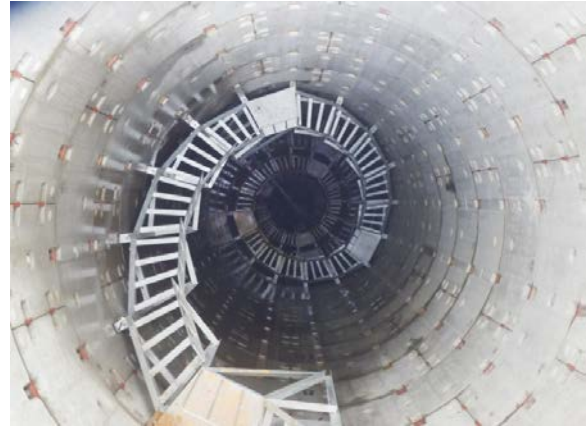
写真-2 施工状況及び集水井内部
