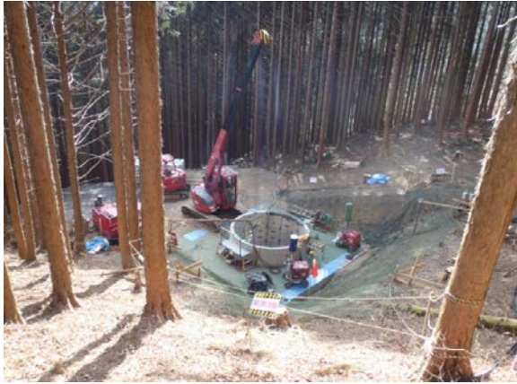
写真-2 施工状況及び集水井内部
