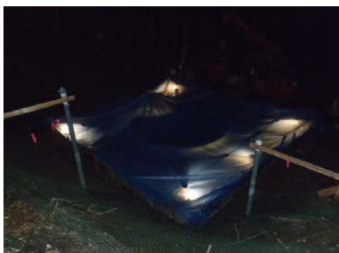
写真-6 コンクリート養生状況
