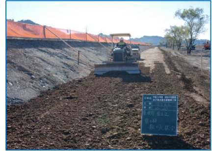
(写真-3) 盛土施工状況
