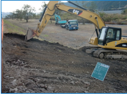
(写真-1) 表土すきとり状況
