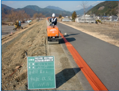
(写真-4) 盛土施工状況（天端部）
