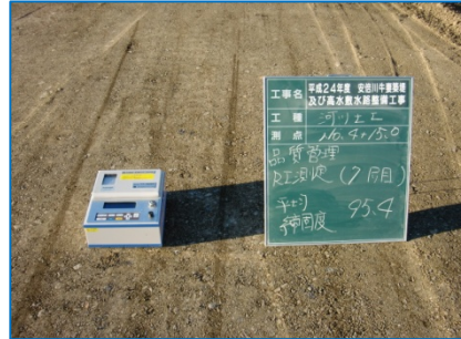
(写真-5) R I 計器による締固め管理
